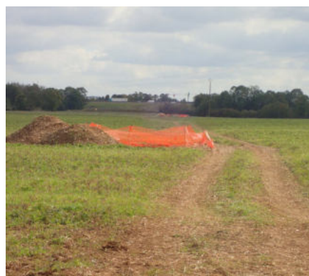
Site des travaux
